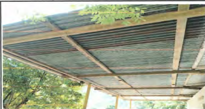
Foto1: Sustrucción de estructura de techo y cubierta de lamina.
