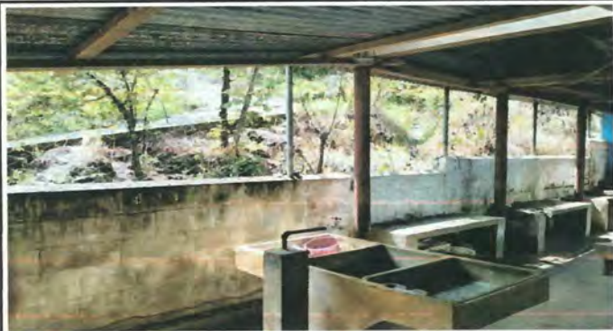
Foto 1: Sustitucion de circulacion malla a block y repello, área cocina.
