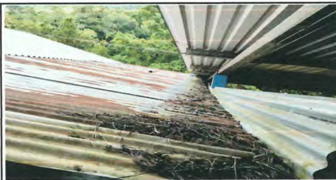
Foto 6: Sustitucion estructura de techo y cubierta de lámina.
