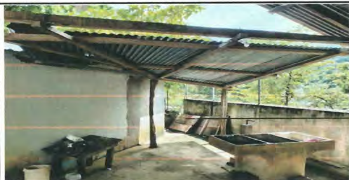
Foto 3: Sustitucion en estructura y entechado corredor de cocina
