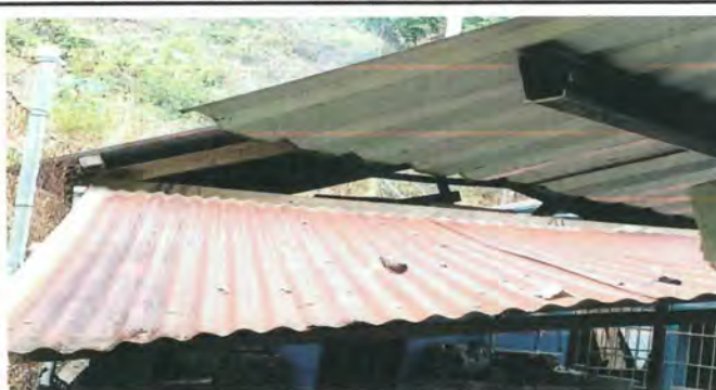
Foto 4: Lado de arriba del techo de la foto 3.
